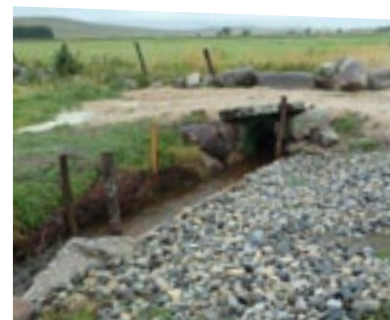
Création d'un passage busé et d'une descente aménagée pour l'abreuvement
