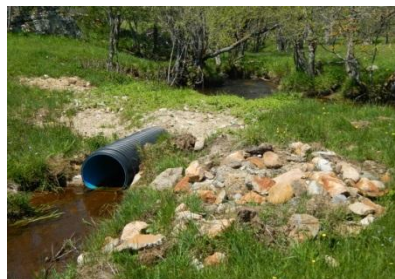
Mauvais positionnement d'une buse sur un petit affluent du Chantagues
