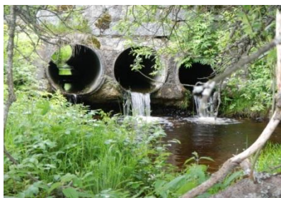
Buse sur les Jasses présentant une forte hauteur de chute, située sous le pont de la D73
